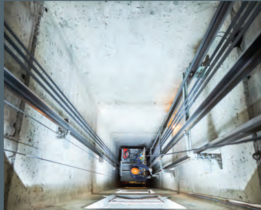
Bei Arbeiten an schwer zugänglichen Stellen, wie Aufzugsschächten.
