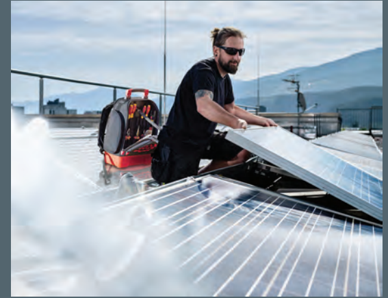
Praktisch bei Arbeiten auf dem Dach, wie im Solaranlagenbau.
